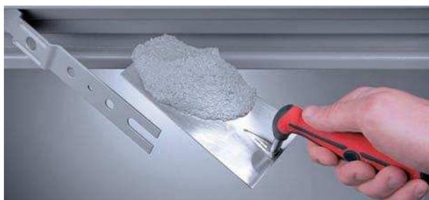
Nel caso di fissaggio con zanche, si consiglia di creare gli scassi adeguati nella parete (sezione 80 x 200 mm) oppure di fissare le zanche con tasselli. Le zanche vanno ripiegate e bloccate nella parete. Ai fini di una buona tenuta meccanica si consiglia di riempire il vuoto tra telaio e muratura con malta cementizia oppure con schiuma poliuretanica.
